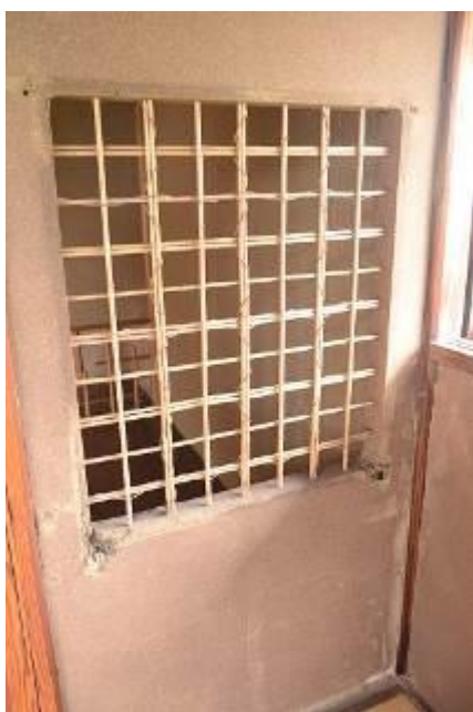
写真 4-11 左官編で改修の検討素材とした清閑亭の剥落した土壁
