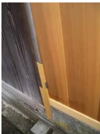
写真4-8 「金沢職人大学校」修了生による民有物件の改修例。柱の根継ぎと板塀の改修
