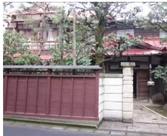
写真 4-3 所有者の意図にそぐわない不適正な改修が行われた佐藤邸の板塀（左手）
