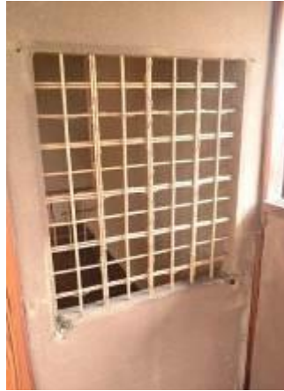
旧黒田長成邸要修理箇所 右：土壁の破損・剥落 左：廊下の沈下
