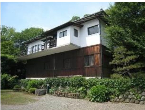
写真 2-3 松永記念館本館
