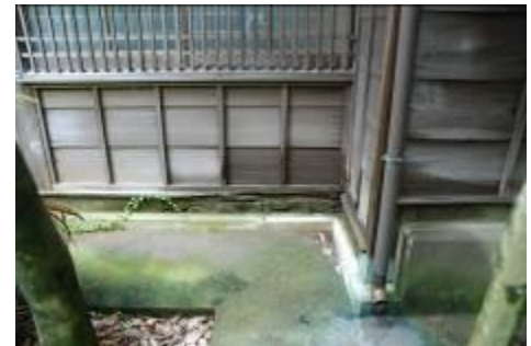
旧田中光顕別邸 上：全景、下：要修理箇所
