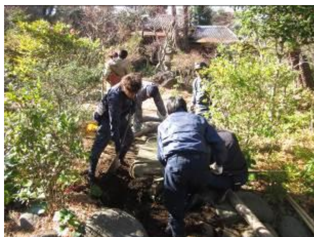
写真4-12 ワークショップにおける教材の改修 上：大工編における茶室連子竹改修の解説。下：造園編における沢渡り石の復元
