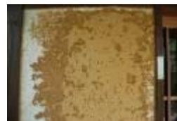
岡田邸要修理箇所 上：母屋基礎不安定化 右：母屋玄関脇土壁剥落 下：茶室雨戸破損
