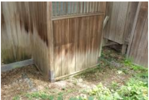
諸戸邸要修理箇所
