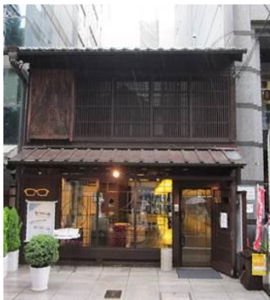
写真5-1 京町家作事組の改修例。現在は眼鏡店として活用されている
