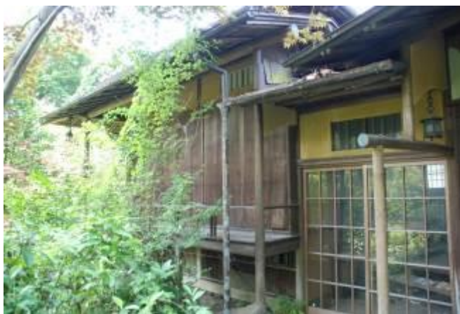
写真 1-2 滅失の危機にある近代和風建築 上：崩壊寸前の諸戸邸下屋庇。下：老朽化が進む岡田邸（旧松本剛吉邸）の茶室
