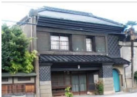
写真 2-6 平成 24 年度調査において対象物件とした内野邸
