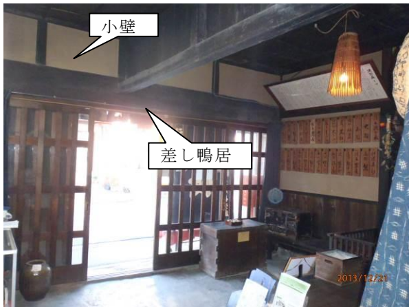
写真 5-35 建築物（1）小壁・差し鴨居
