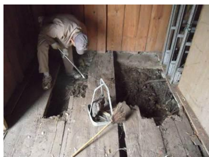
写真 5-49 1階床板の腐朽個所の改修
