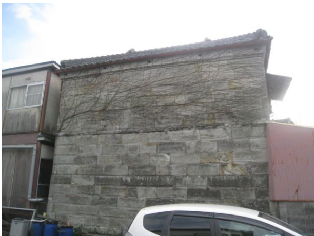
写真 5-73 藁の繁殖による、石の割れ目、目地への浸食が懸念される
