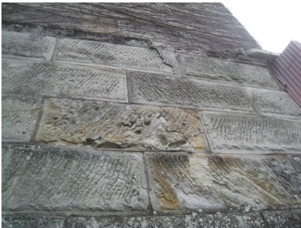
写真 5-71 伊豆石の劣化による剥離がみられる
