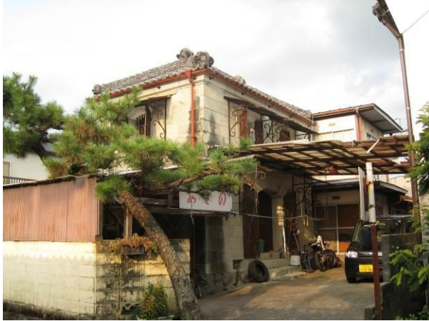
写真 5-63 外部 西・南面
