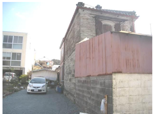
写真 5-77 敷地境界線近くに建つ蔵、隣地は駐車場
