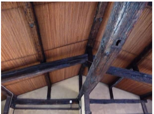
写真 5-27 2階和室広間:小屋組み
