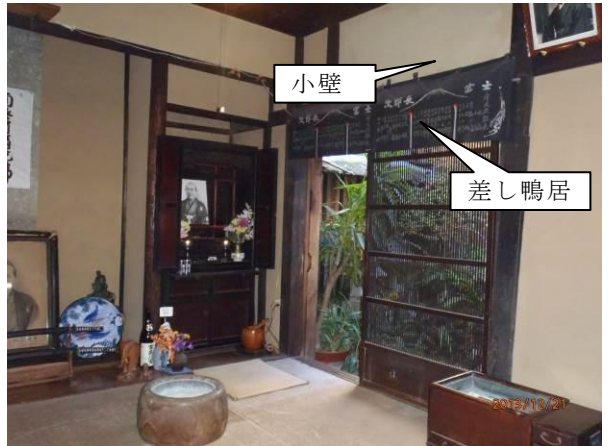
写真 5-36 建築物（1）小壁差し鴨居
