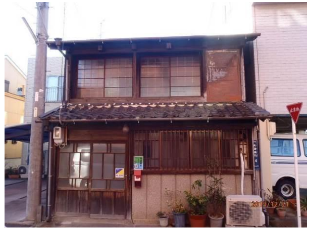
写真 5-32 裏玄関 2階の出し桁はまったくの化粧である
