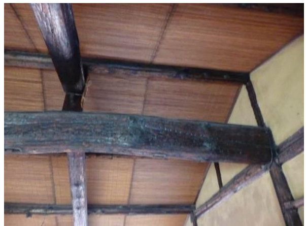
写真 5-28 構造材に黒炭:火事の痕跡か
