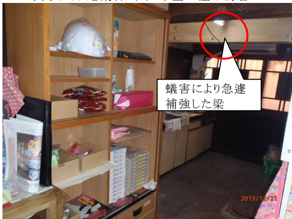
写真 5-37 建築物（2）事務所内
