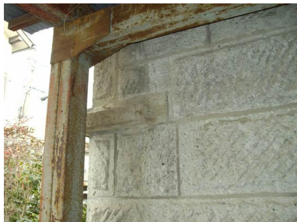
写真 5-60 外壁石状況 目地補修
