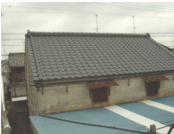
写真 5-59 屋根葺き替え 軒樋交換
