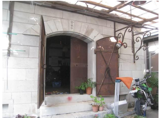
写真 5-66 1階 南側出入口
