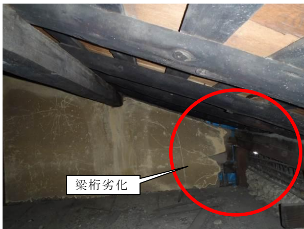
写真 5-33 建築物（1）屋根裏内
