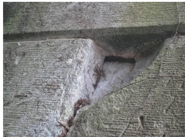
写真 5-72 鋸の錆により部分的に割れ、落下した
