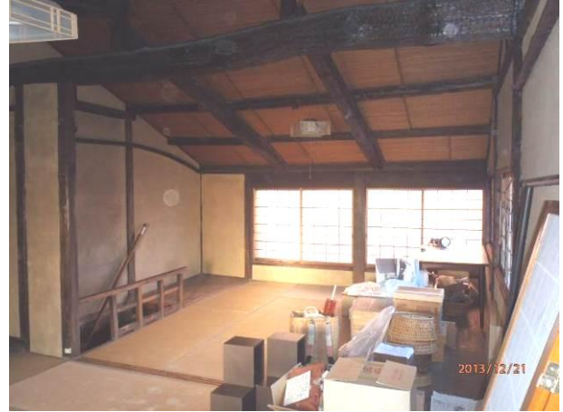
写真 5-30 2階和室広間:階段方向を見る
