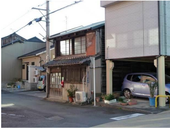
写真 5-31 裏通りからの外観
