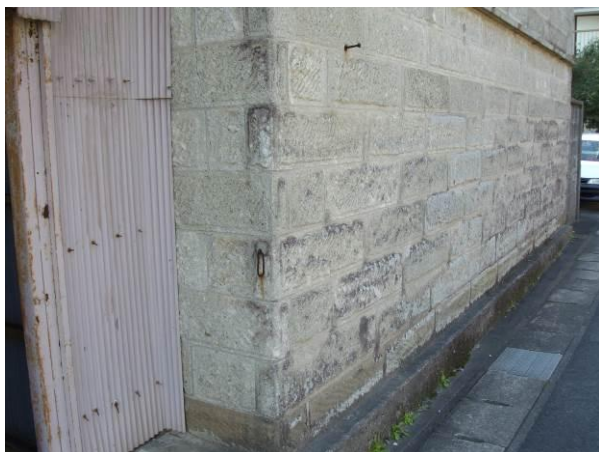
写真 5-61 外壁石亀裂状況
