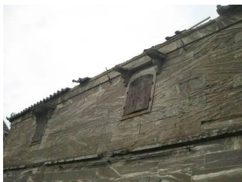
写真 5-47 平成 23 年台風による被害
