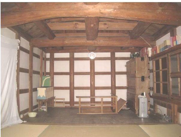
写真 5-76 構造用合板による耐震壁予定箇所
