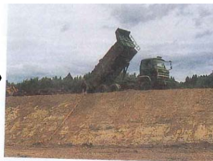
ダンプトラックによる排出作業
