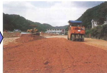
ブルドーザによる敷均し、タイヤローラによる締固め作業
