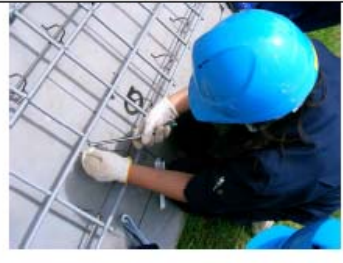
鉄筋結束実習
