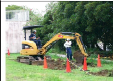
建設機械運転実習
