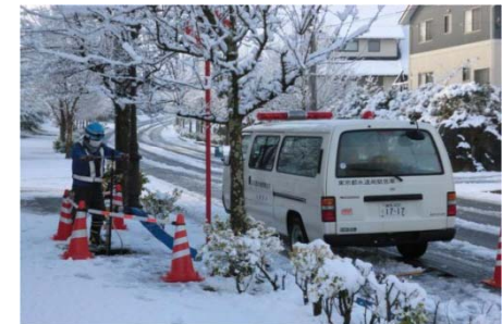
仙台市内で通水に向けた排水作業を行う支援事業者
