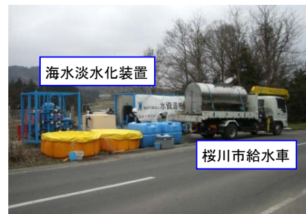
桜川市給水車への補給状況
