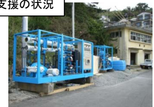
海水淡水化装置設置状況
