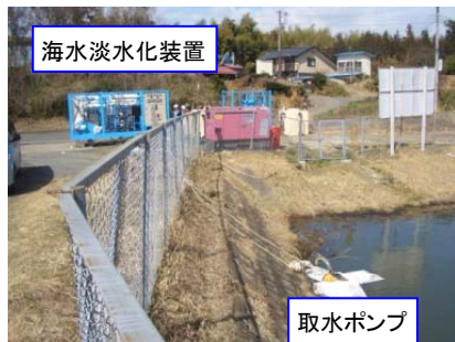
海水淡水化装置により農業用ため池の水を飲料水に浄化
