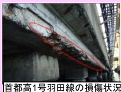
首都高1号羽田線の損傷状況
