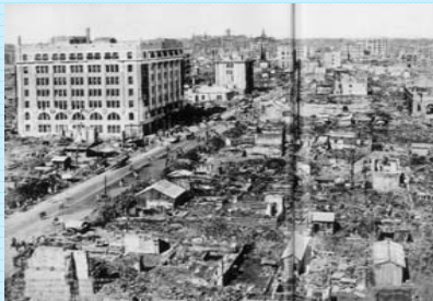
被災後の様子(東京都京橋)
