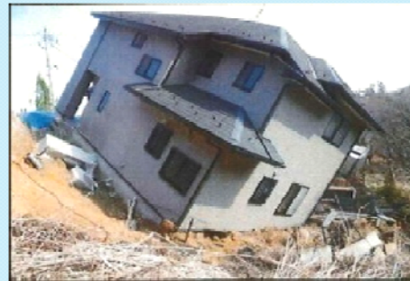
宅地の滑動崩落 (仙台市青葉区)
