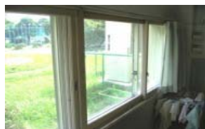
防音サッシ設置
