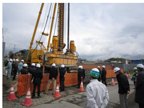
ALiCC 工法現場見学会 現場見学の状況（さいたま市）
