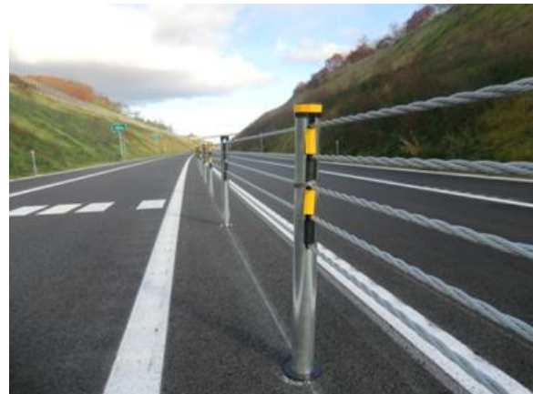
写真-1 高速道路に導入された ワイヤーロープ式防護柵
