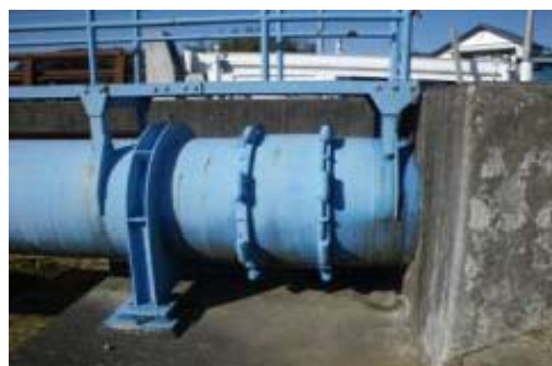
水管橋橋台部
