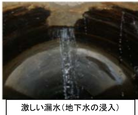
有馬トンネルの老朽化状況
