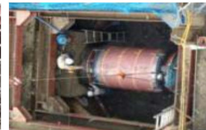
可とう管の変位及び取替状況(成田用水H24. 11. 30)
