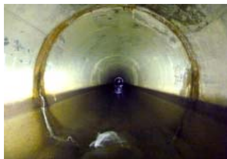
トンネル構内
