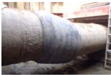
可とう管の変位及び取替状況(成田用水H24. 11. 30)
