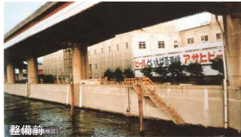
隅田川 吾妻橋地区の例 (東京都)
