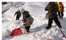
転落防止対策（命綱、アンカー）
