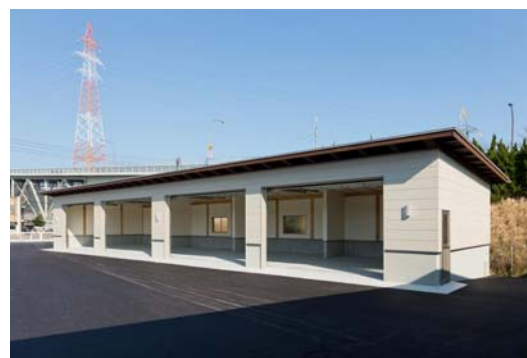
神戸税関境支署(車庫棟)
