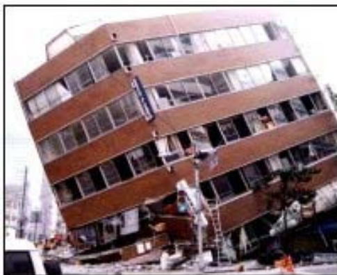
事務所ビル1, 2階の崩壊
