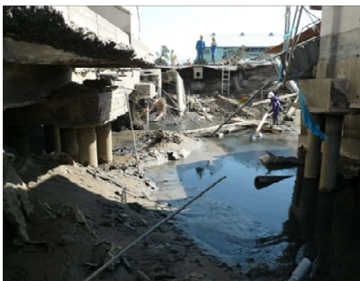
庁舎周囲の地盤流出
