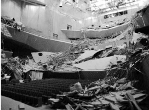
ホール天井の脱落
