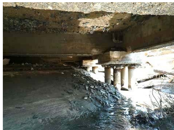
建物基礎が露出
