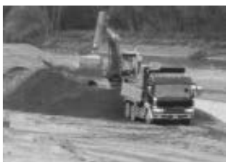
十勝川河道掘削
