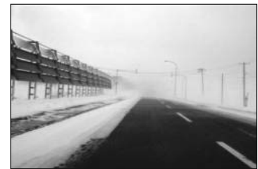
防雪柵の設置
