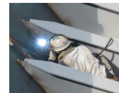
難しい体制での溶接作業
