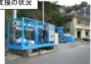
海水淡水化装置設置状況
