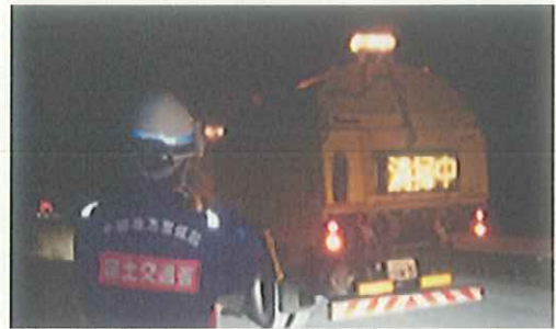
路面清掃車による降灰除去 (9/28)
