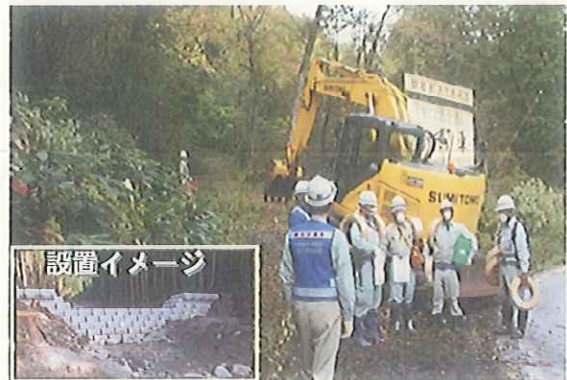
堰堤設置作業に着手 (10/4)
