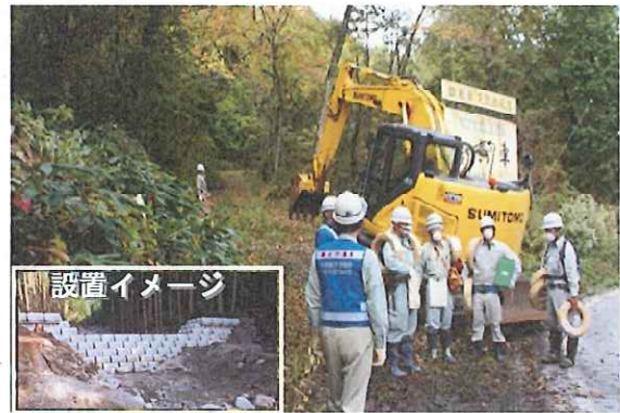
堰堤設置作業に着手 (10/4)
