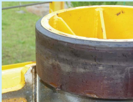
送り出し装置のローラの損傷
