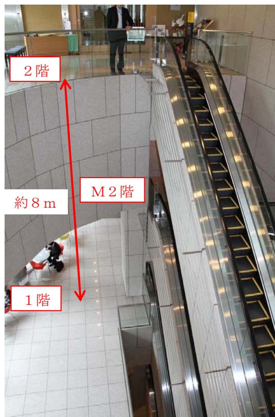
写真1. 事故が発生した吹抜け部分
