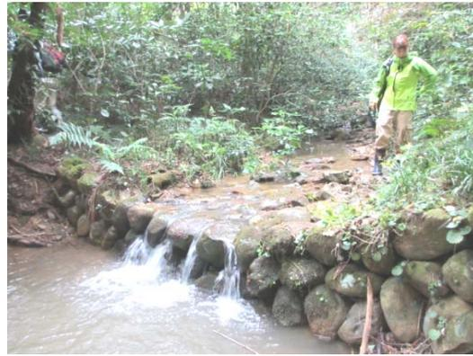
写真 3-9 谷ノ入沢沿いの玉石積み護岸 写真 3-10 玉石積みによる堰
