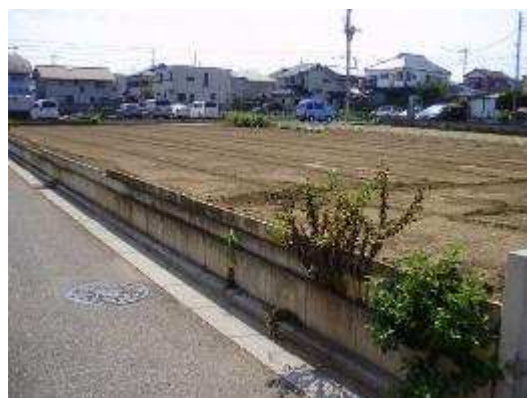
写真3 盛土され道路面より高くなっている
