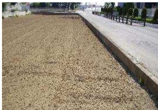
写真1 周辺道路との間に高低差がある
