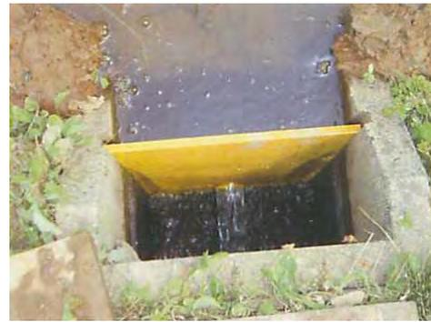
図 3.23 布目池水位のシミュレーション結果 図 3.24 三和錦川地区調整板設置状況
