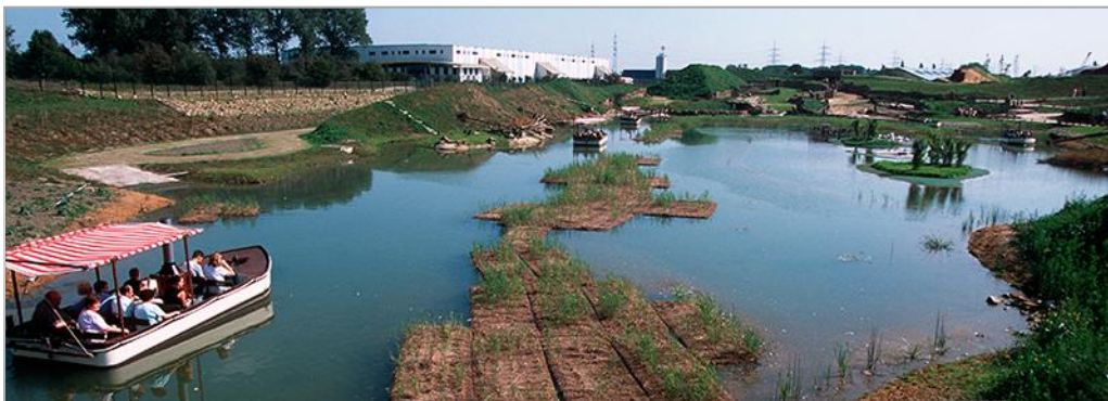
53 箇所の遊水池により、3.8 百万 m 3 の貯水量を有する
