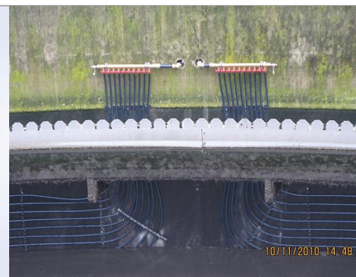
下水処理水の利用 – 最終沈殿池での熱回収
