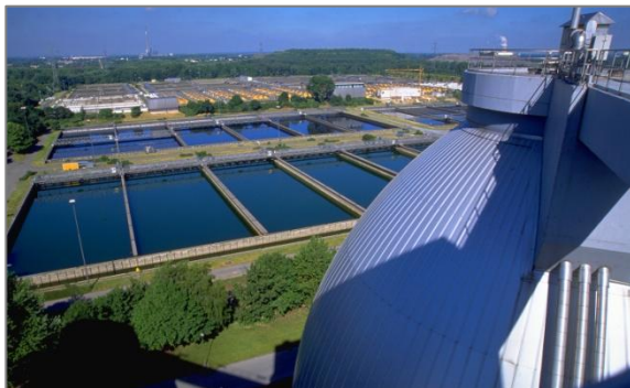
エムシャー河口の下水処理場
