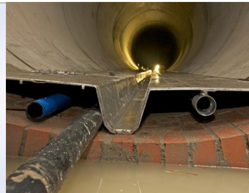
下水管底面に配置する型式の熱交換器
