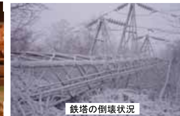
鉄塔の倒壊状況
