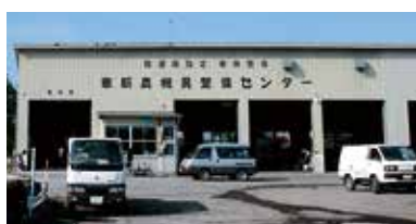
車輛整備工場
