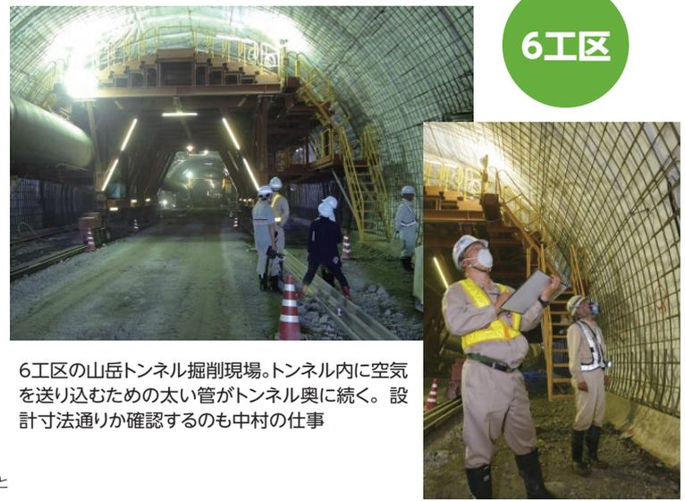
6工区の山岳トンネル掘削現場。トンネル内に空気を送り込むための太い管がトンネル奥に続く。設計寸法通りか確認するのも中村の仕事
