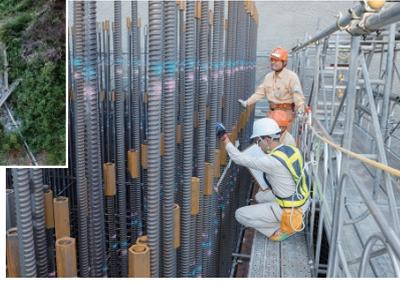
紀北西道路の中でもっとも高所作業の多い7工区の現場。赤茶色の橋脚は工事用の仮設橋で実際の橋脚はその下の鉄筋が組まれている箇所から作る。一番高いところでは高さ約100mにもなる
