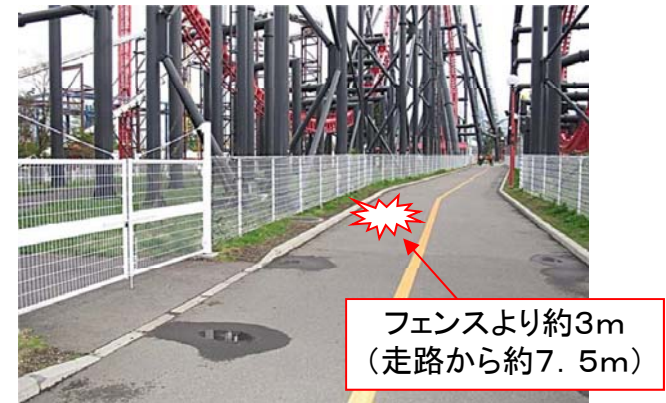
写真1. ボルト落下場所
