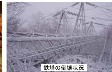
鉄塔の倒壊状況
