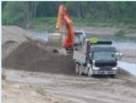
十勝川河道掘削
