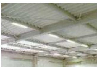
屋根用折板石綿断熱材
