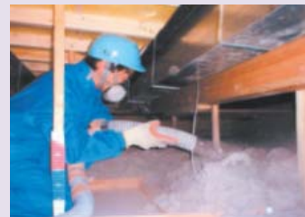
天井の断熱改修
