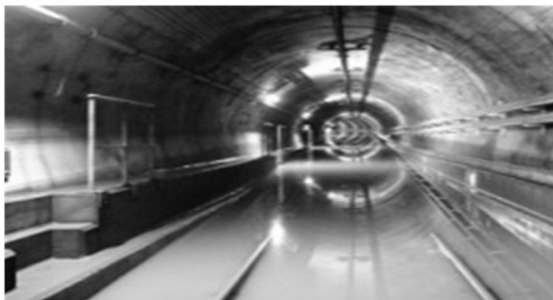
H25.9 京都市交通局(御陵駅及びトンネル) 台風による安祥寺川の氾濫 (4日間運休、約45万人に影響)
