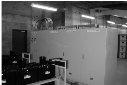
【通信設備の一例】
