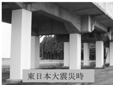
【高架橋の補強】
