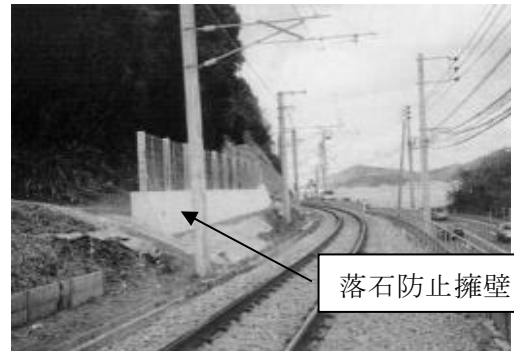
【落石防止擁壁の一例】
