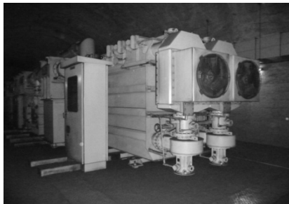
【変電所設備の一例】
