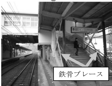
【橋上駅の補強】
