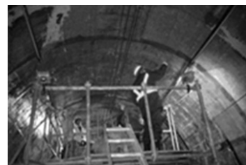
繊維シート貼付
