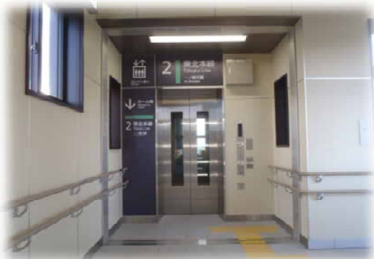
エレベーター設置
