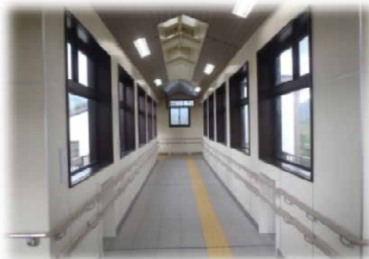
跨線橋内通路
