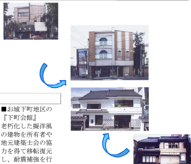
ファサード改修事例
