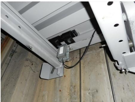
写真：過荷重検知装置
