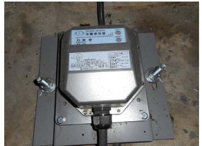
写真：地震時管制運転装置(拡大)
