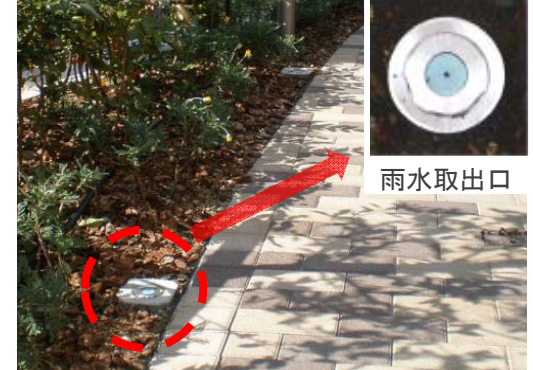
雨水を利用した打ち水や散水
