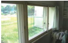
防音サッシ設置
