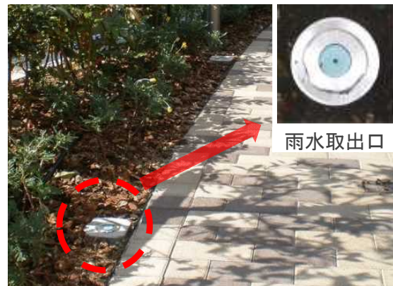
雨水を利用した打ち水や散水
