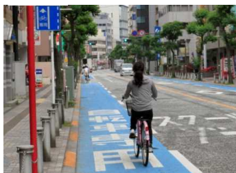
路肩等の空間を活用した自転車専用通行帯の整備
