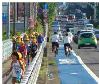
＜歩道整備による通学路対策＞
