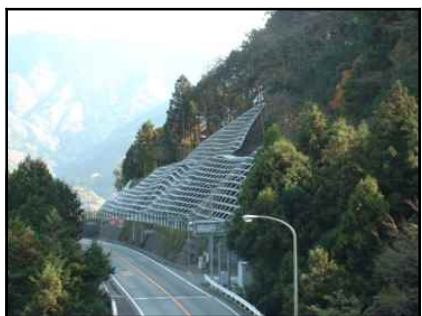
<斜面崩落防止対策>
