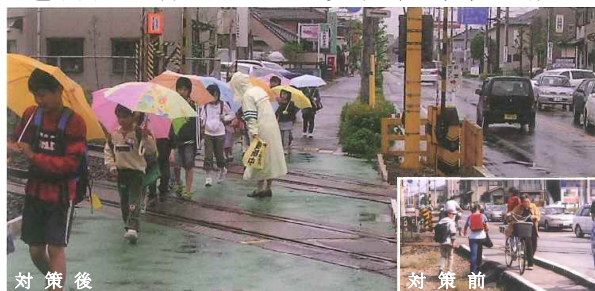
＜踏切道の歩行者対策(歩道の設置・拡幅)＞ (JR東北本線 市道6110号線(栃木県宇都宮市))
