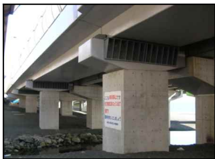
<橋梁の耐震補強>
