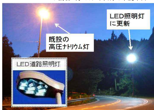
＜LED道路照明灯の整備＞
