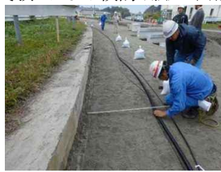
ケーブルを直接埋設している状況
