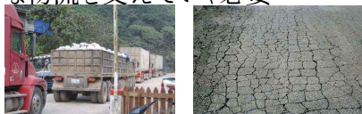
ラオスにおける大型車両と損傷した舗装
