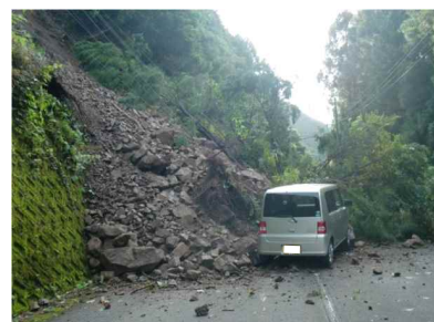
< 災害時に通行不能となった箇所 >
