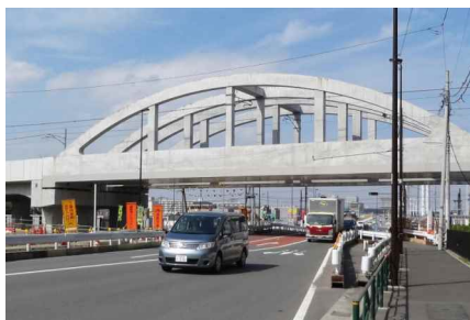
＜鉄道高架化により踏切15箇所を除却＞ (JR南武線連続立体交差事業(東京都))
