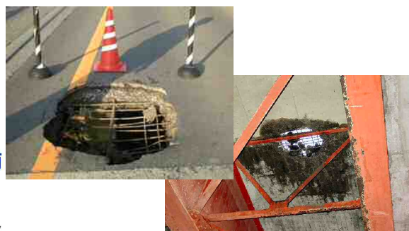
＜抜け落ちた橋梁のコンクリート床版＞
