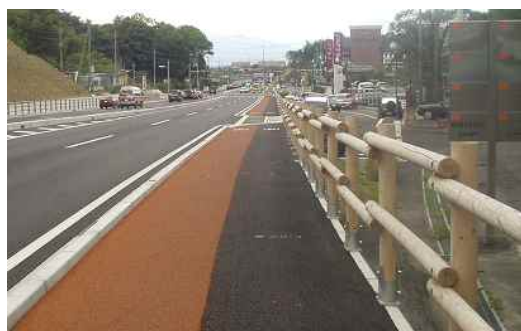
＜歩行者自転車用木製防護柵＞ (県道 高崎神流秩父線・群馬県高崎市)
