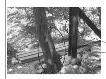
写真② 軌道側 既設落石防護柵損傷
