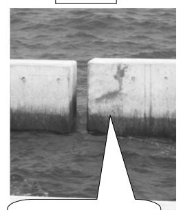
損傷部分の補修をしたものの、 施工管理がされておらず、補修 方法にも不備があった。
