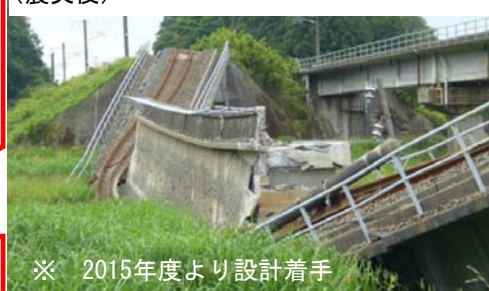
夜ノ森・大野間のり面崩壊（震災後）
