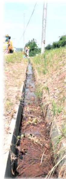
【除去前の農業用水路】
