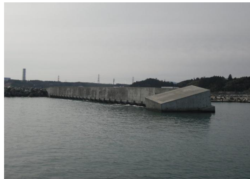
② 転倒した内防波堤
