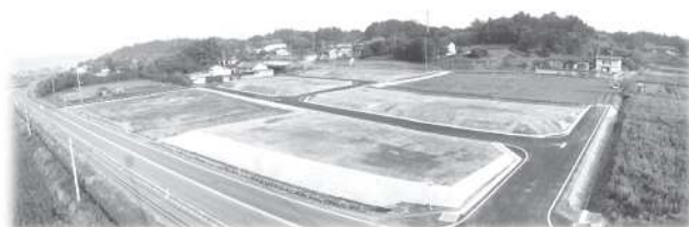
【鹿島区北海老地区】（造成完了当時）
