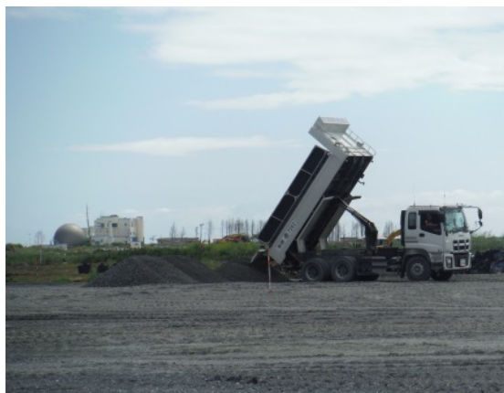
造成中の災害廃棄物仮置場（棚塩地区 / 9月）
