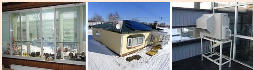
内窓サッシを取り付けたリフォーム部門参加者宅（左）、太陽光発電（中）、エコキュートを取り付けたモニター部門参加者宅（右）
