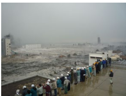
被災の状況（南蒲生浄化センター）
