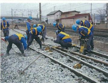
バラスト突き固め (分岐区間)
