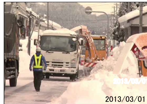
写真1 運搬排雪状況
