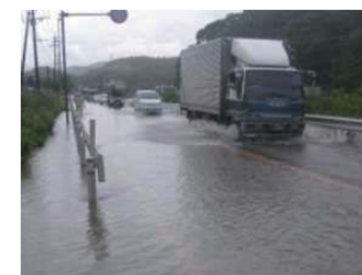
写真3 国道3号の路面冠水状況
