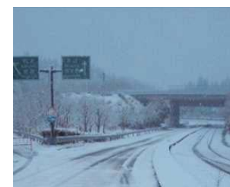
写真4 九州縦貫自動車道の積雪状況
