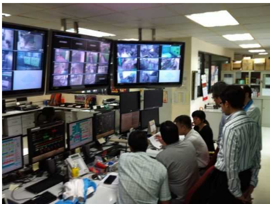
Sham Tseng 下水処理場
