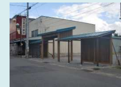
■空き地に設置された仮設のこみせ
