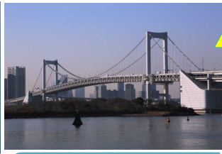
Rainbow Bridge Jan.1987~Jun.1991 798m Center Span:570m
