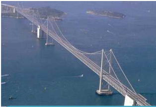
Minami Bisan & Kita Bisan Seto Bridge Jul.1982~Jun.1985 1,611m (Minami) 1,723m (Kita)
