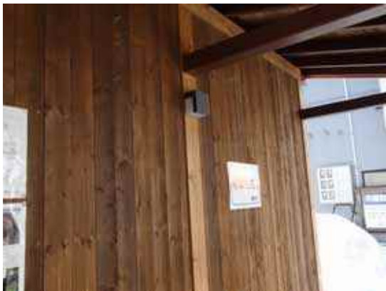
仮設こみせに設置した照明
