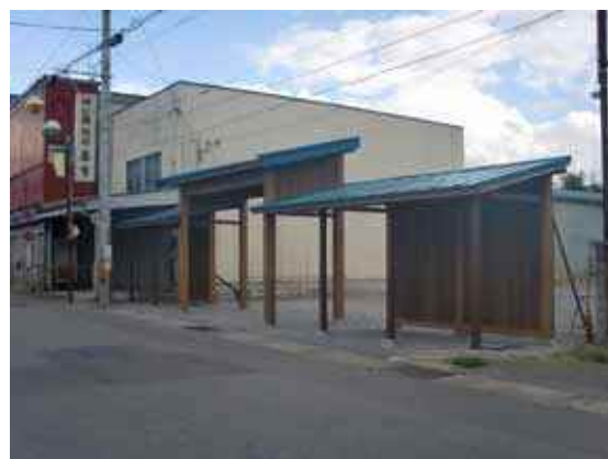
仮設こみせの建設後
