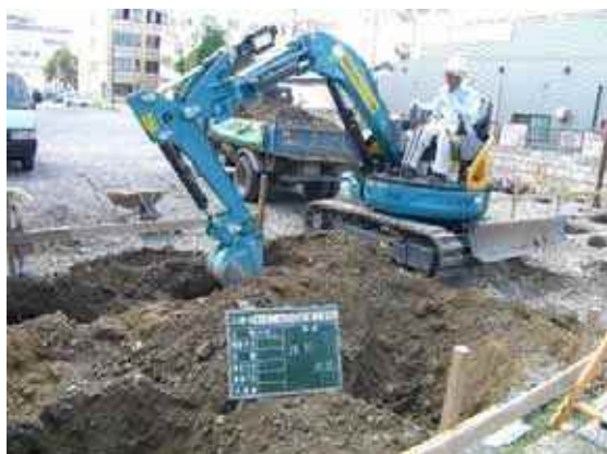
写真3-1 仮設こみせ建設の様子
