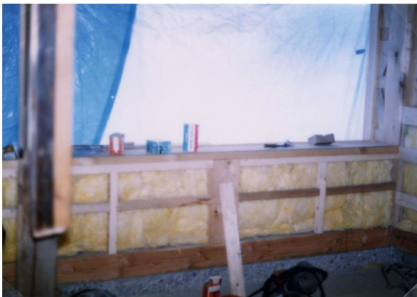
壁 グラスウール充填 建物内部から施工
