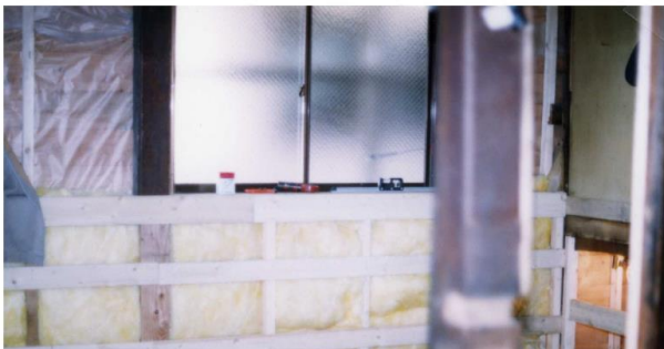
写真 3-3 壁（断熱材充填）
