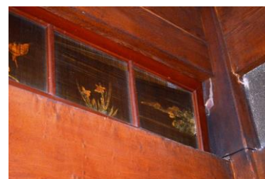
写真 2-2 糸ガラス欄間 （細い糸状のガラスを編込んで板状にしたもの）
