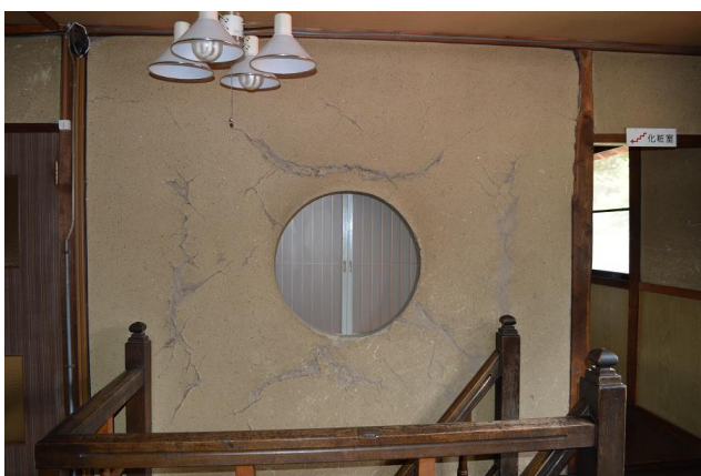
写真 4-10 内部の土塗り壁
