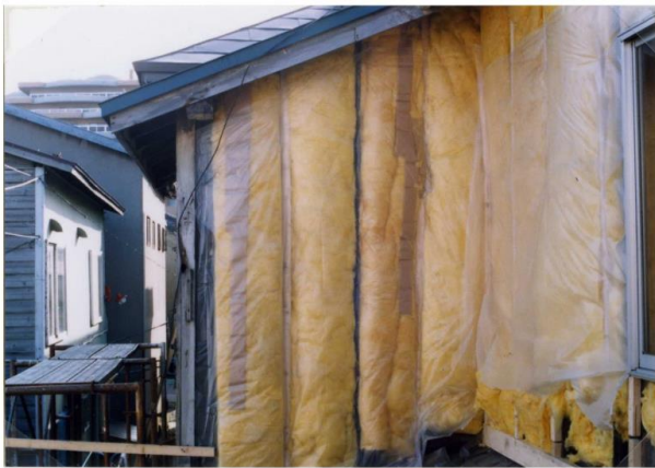
壁 グラスウール充填 外壁側から施工
