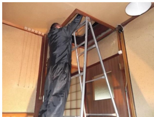
写真 4-3 小屋裏の確認
