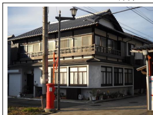
事例1（改修事例）
