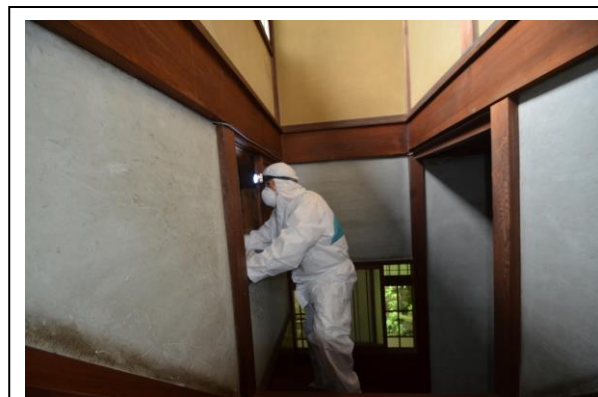
防塵服に身を固めて小屋裏へ
